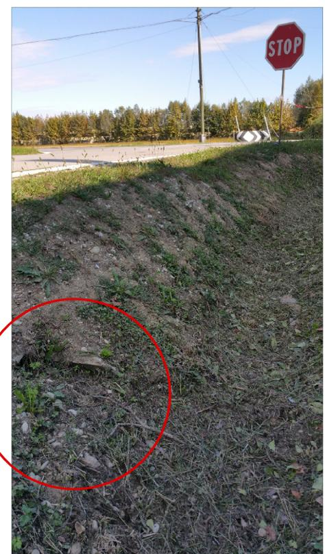
FOTO 5: ATTRAVERSAMENTO VIA PETRARCA MEDIANTE TOMBINAMENTO ESISTENTE CON COLLETORE CIRCOLARE IN CLS Ø600 (PARZIALMENTE OCCLUSO)
