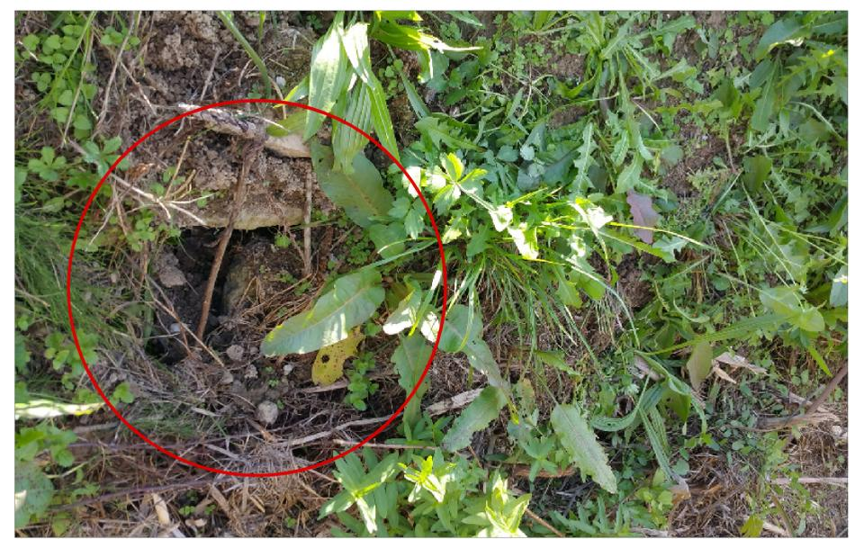
FOTO 3: ATTRAVERSAMENTO VIA PETRARCA MEDIANTE TOMBINAMENTO ESISTENTE CON COLLETORE CIRCOLARE IN CLS Ø600 (PARZIALMENTE OCCLUSO)
