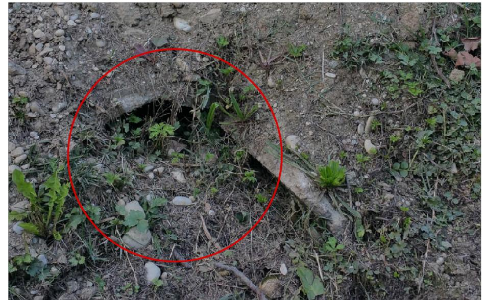
FOTO 4: ATTRAVERSAMENTO VIA PETRARCA MEDIANTE TOMBINAMENTO ESISTENTE CON COLLETORE CIRCOLARE IN CLS Ø600 (PARZIALMENTE OCCLUSO)
