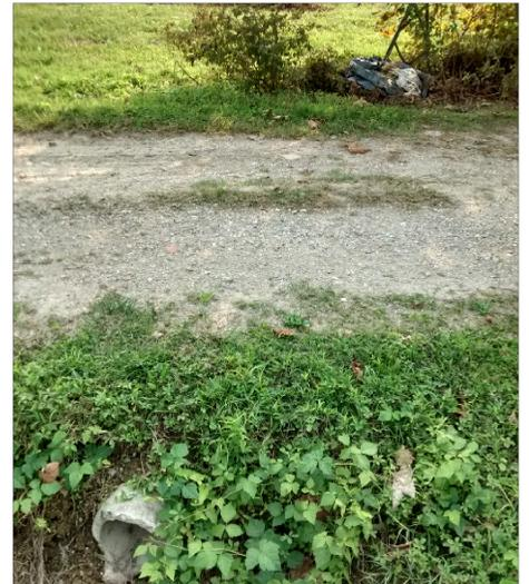
FOTO 2: ATTRAVERSAMENTO STRADA BIANCA PRIVATA MEDIANTE TOMBINAMENTO ESISTENTE CON COLLETORE CIRCOLARE IN CLS Ø300
